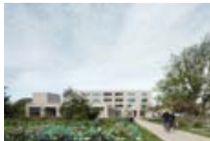
OO 2704 Project Sint-Monica Oostende Plaats Nieuwpoortsesteenweg 757-759, 8400 Oostende Programma Woon- en zorgcentrum, assistentiewoningen, dag-verzorgingscentrum, medisch-sociaal centrum en publiek restaurant Bouwheer Sint-Monica vzw Ontwerp Bovenbouw architecten Bouwjaar 2019
