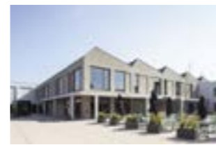
OO 1519 Project Cultureel centrum en bibliotheek Bornem Plaats Sint- Amandsesteenweg 41-43, 2880 Bornem Programma Cultureel centrum en bibliotheek Bouwheer Gemeentebestuur Bornem Ontwerp Planners Bouwjaar 2017
