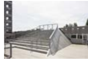
OO 1904 Project Campus Vesalius Gent Plaats Keramiekstraat 80, 9000 Gent Programma Auditoria Bouwheer Hoge- school Gent Ontwerp Marc Koehler Architects Bouwjaar 2017
