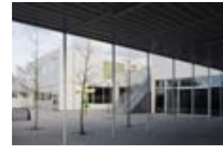
OO 1924 Project BS Klim Op Vilvoorde Plaats Ledeganckstraat 16, 1800 Vilvoorde Programma Basisschool Bouwheer School Invest Ontwerp PT architecten Bouwjaar 2016
