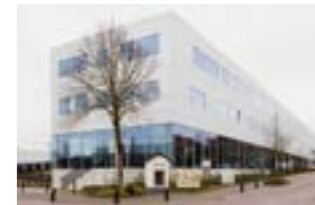
OO 1928 Project KTA Pro Technica Halle Plaats Sint-Gerolffaan 20, 9880 Aalter Programma Secundaire school Bouwheer School Invest Ontwerp Stéphane Beel architecten Bouwjaar 2017
