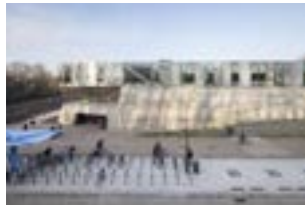
OO 2017 Project Topsportschool Wilrijk Plaats Edegemsesteenweg 100, 2610 Wilrijk Programma Sport- school Bouwheer AG VESPA Ontwerp Compagnie O Bouwjaar 2016
