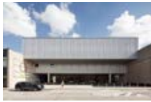
OO 1929 Project Emmaüsinstituut Aalter Plaats Sint-Gerolfaan 20, 9880 Aalter Programma Secundaire school Bouwheer School Invest Ontwerp VMX architects Bouwjaar 2016
