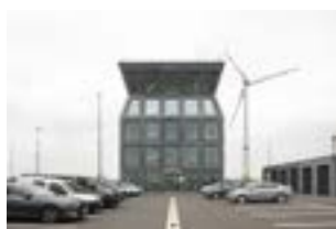
OO 1501 Project Sluis Waaslandhaven Plaats Sint-Antoniusweg, 9120 Beveren- Waas Programma Sluisbedienings- gebouw en aanverwante gebouwen en inrichting sluis- plateau Bouwheer VO Afdeling Maritieme Toegang Ontwerp Verne, Bar architecten Bouwjaar 2016
