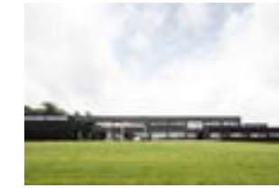
OO 2211 Project BSO De Dageraad Kortesseem Plaats Tapstraat 12, 3720 Kortesseem Programma Buitengewoon secundaire school Bouwheer GO! Onderwijs van de Vlaamse Gemeenschap Ontwerp Puls Architecten Bouwjaar 2016
